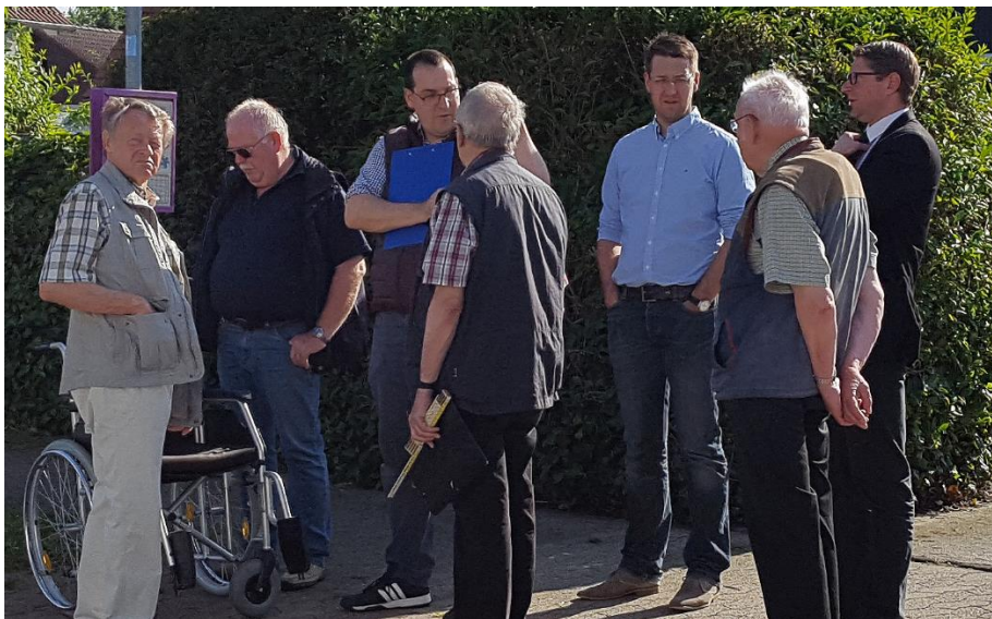
Vertreter der CDU Sickte mit einem Rollstuhl bei der Inaugenscheinnahme der fehlenden Barrierefreiheit auf dem Backhausweg in Sickte
